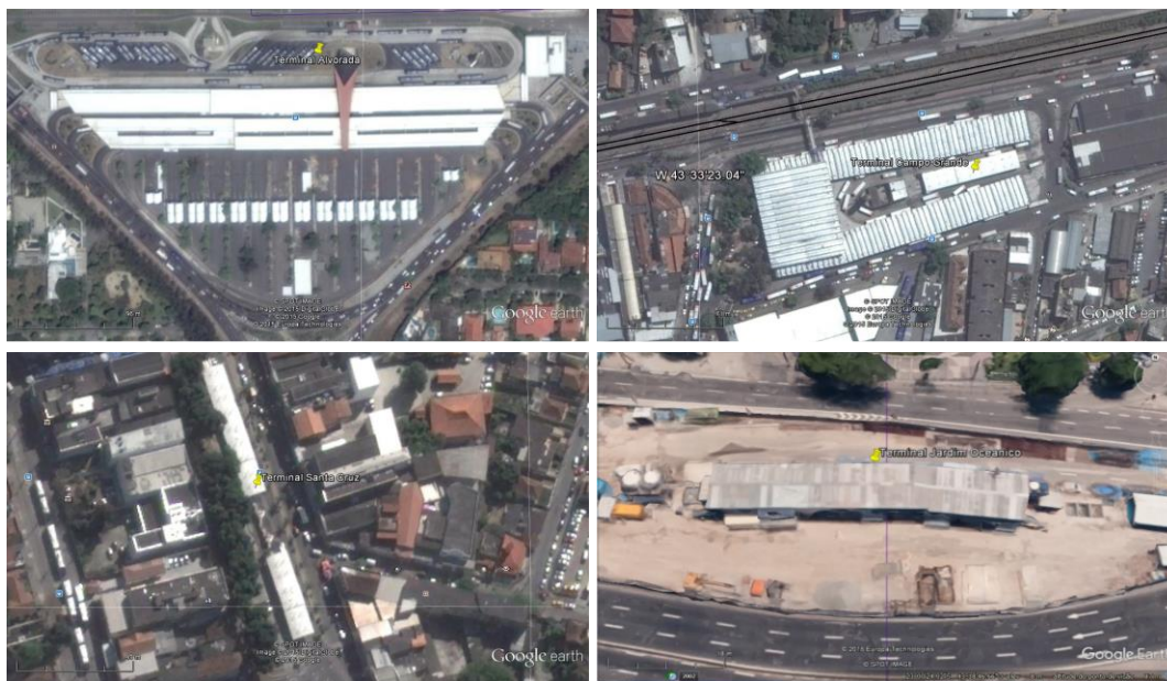
Figura 37 – Imagens de Satélite dos Terminais Existentes no BRT TransOeste.
