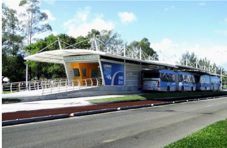
Figura 36 – Estação Típica no BRT TransOeste.
